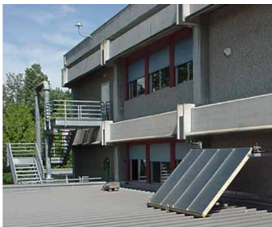
Istituto di Istruzione Superiore "I. Calvi", Finale Emilia: costruzione di pannelli solari da parte degli alunni
